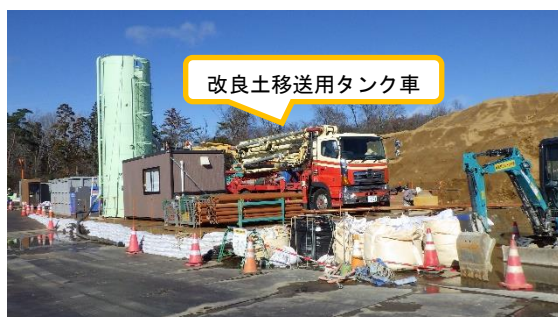
(写真1①) JAEA第2棟 工事残土の利用による改良土製作及と注入の準備状況①
