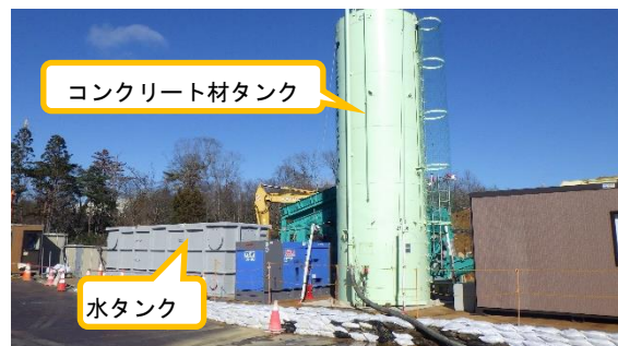
(写真1②) 改良土の製作及と注入の準備状況②
