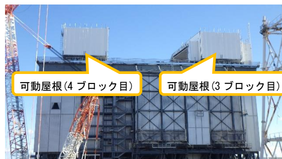
(写真2②) 可動屋根(3、4ブロック目)の設置状況
