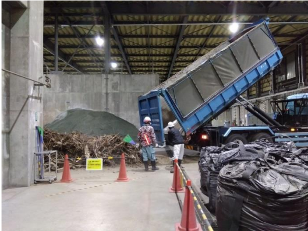
受入ヤード（焼却施設） 異常なし
