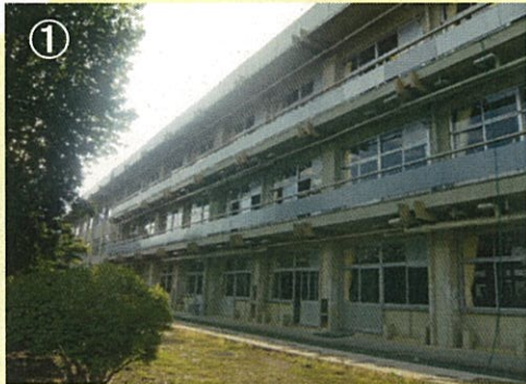
① 路線名：白河高校 事業名：白河高校耐震改修工事 事業場：白河市南登り町地内 工事説明：校舎の耐震化を図るため壁の増設やブレースを設置し耐震性能を向上し、安全で良好な教育環境の提供を図ります。
