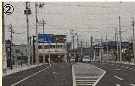
② 路線名：国道294号 事業名：交付金事業 場所：白河市西大沼～萱根地内 工事説明：白河市の中心部を通る都市基盤である国道294号のバイパス整備により、中心市街地の交通混雑の緩和と活性化を促進します。
