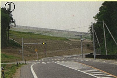
① 路線名：国道294号 事業名：交付金事業 場所：白河市豊地地内 工事説明：県南地方の広域幹線道路であり、幅員狭小及び線形不良区間の解消を図るとともに、物流拠点である「工業の森」と白河中央SIC及び国道4号を連携するネットワークを形成し、物流事業の促進を図るため、道路拡幅の整備を促進します。
