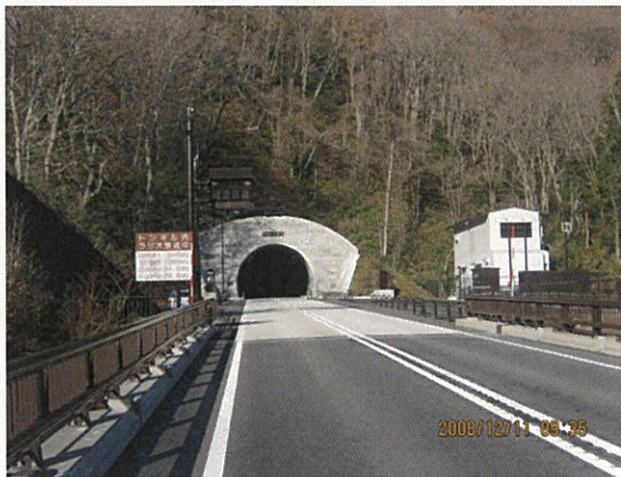
甲子トンネル西郷側坑口
