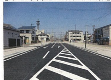
白河駅白坂線大工町工区(白河市)
