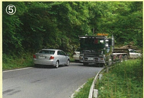
⑤ 路線名：国道289号 事業名：交付金事業 場所：東白川郡鮫川村大字渡瀬地内 工事説明：渡瀬バイパスは本県長期総合計画の中で七つの生活圏の連携を支える「南部軸」として位置づけられている重要路線であり、本道路の線形不良、幅員狭小区間の解消を図り、県南地方といわき地方を結ぶ広域連携促進を目的にバイパス整備を促進します。
