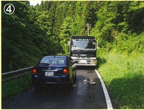
④ 路線名：勿来浅川線 事業名：地方特定道路整備事業 場所：東白川郡鮫川村大字赤坂東野地内 工事説明：県南地方(東白川郡)広域幹線道路であるとともに、スクールバスや緊急車両等の通行がある生活道路としても必要性の高い道路であり、2車線化による道路線形及び幅員狭小の改良を図り、安全で円滑な交通を促進します。
