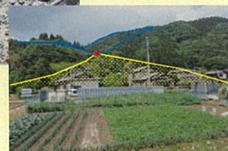
河川名：滝ノ沢 事業名：交付金事業 場所：東白川郡矢祭町大字関岡地内 工事説明：土石流による土砂災害を防止するため、砂防えん堤工の施工を進めています。
