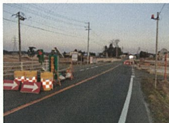
棚倉矢吹線(矢吹町) 三文橋
