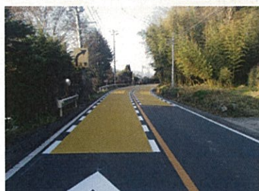
国道118号(矢祭町) 東館地内
