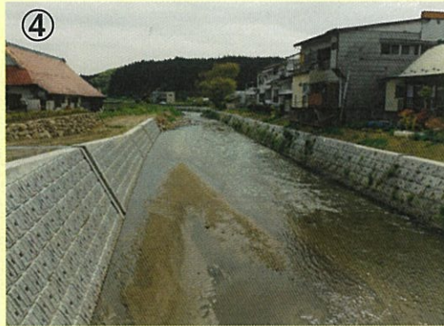
河川名：渡瀬川 事業名：河川海岸改良事業 場所：東白川郡鮫川村大字渡瀬地内 工事説明：村道や住宅の浸水被害を防止するため、河道拡幅や護岸工の施工を進めています。
