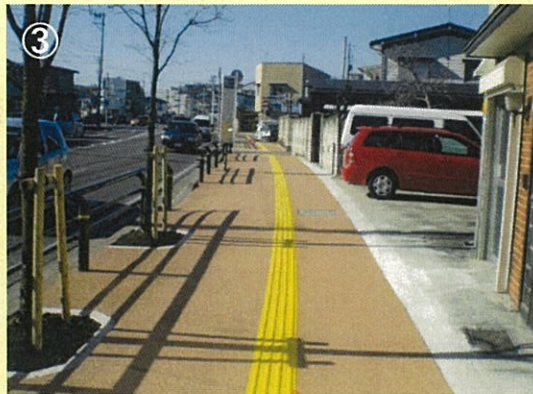
路線名：白河羽鳥線 事業名：やさしい道づくり推進事業 事業所：白河市道場小路地内 工事説明：快適な歩行空間づくりを進めるため、歩道の段差解消および視覚障がい者用ブロックや透水性舗装の整備を進めています。
