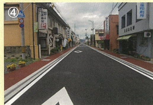
路線名：塙大津港線 事業名：交付金事業 事業所：東白川郡塙町大字塙地内 工事説明：快適な道路空間づくりを進めるため、歩道の段差解消および歩道内の電柱移転を進めています。
