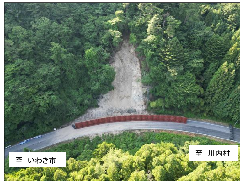
応急対策後の状況
