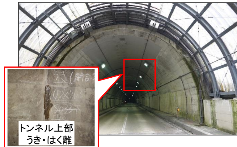
国道118号 蟬トンネル(下郷町)
