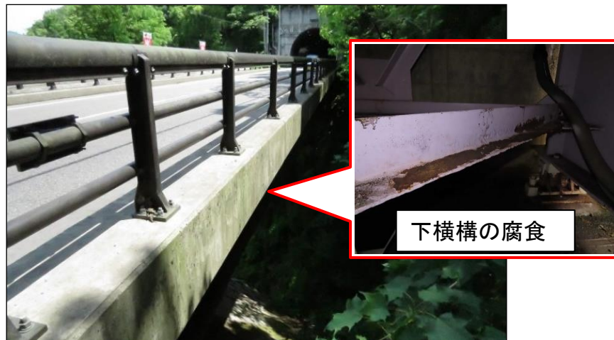
国道252号 川井橋(三島町)
