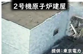
1号機の爆発の衝撃で開いたパネルから水素が外に排出されたため、爆発しなかった。
