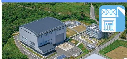
JAEC福島遠隔技術開発センター 廃炉作業の実証実験(※1)
