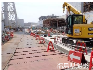
フェーシング前 (3号機付近)
