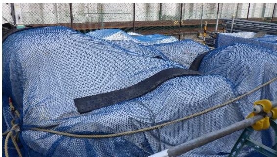
(写真 5) 資機材等の仮置き状況
