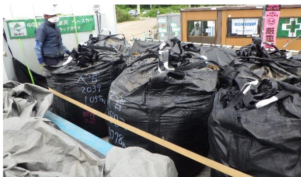
飛散・流出防止対策（固縛）
