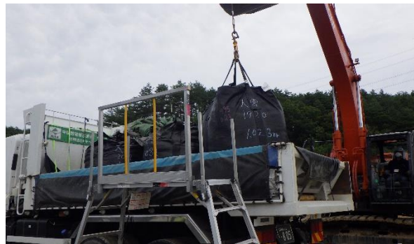
除去土壌の積込作業
