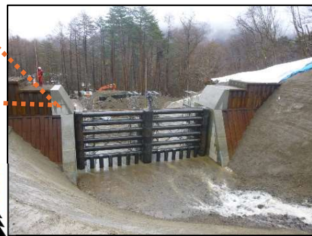
(参考) 中ノ沢川砂防えん堤
