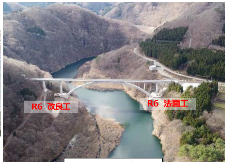
令和6年度工事箇所
