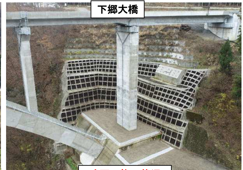
法面工施工状況
