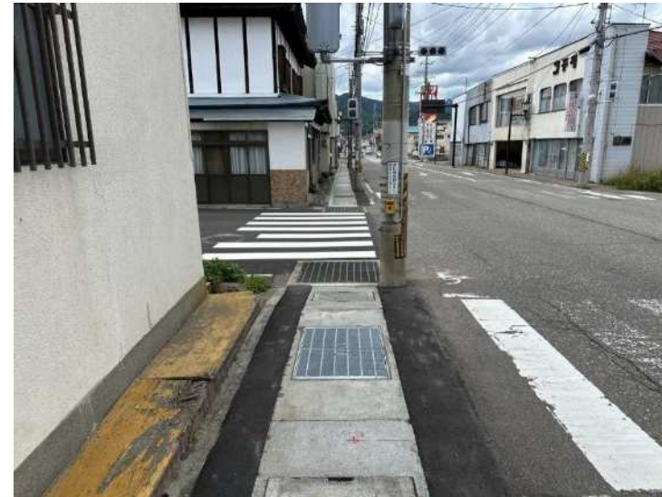
R6工事完了後
