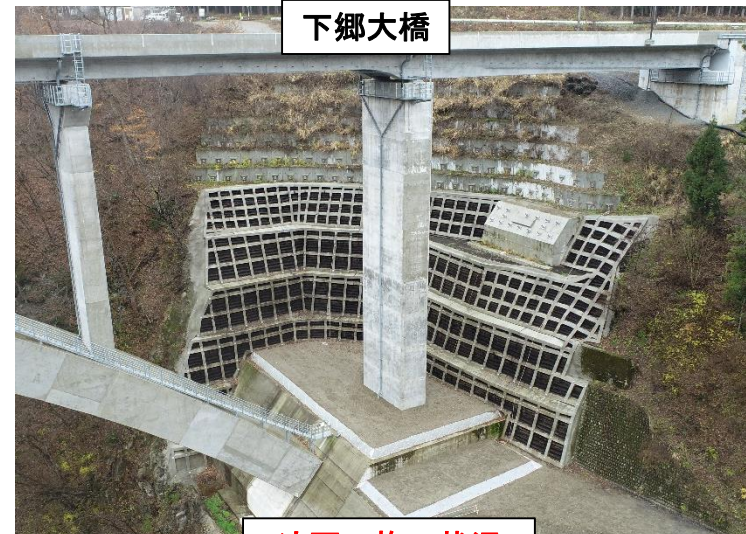
法面工施工状況
