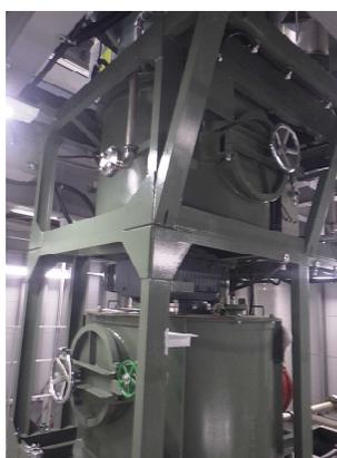
ドラム缶に入れた固体廃棄物をモルタルで固型化するための設備。
