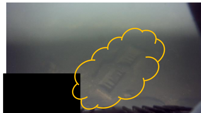
干渉物の例 (落下したダクト) ※移置済
