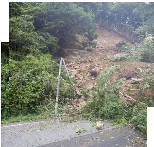
地上からの被災状況
