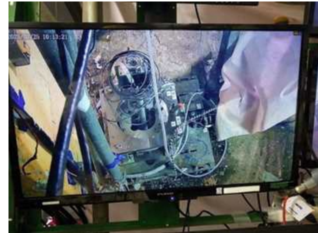
<1号機原子炉建屋3階の穿孔箇所の様子>
