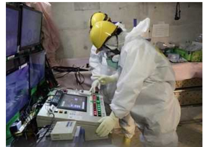
<1号機大物搬入口 遠隔操作室>
