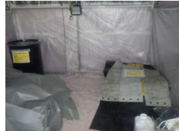
<ドラム管他仮置き状況>
