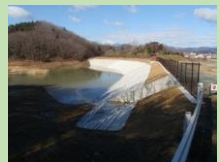
老朽化したため池の改修
