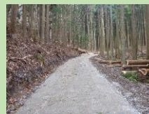
森林作業道の開設
