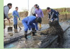
地域ぐるみでの堰の土砂上げ作業
