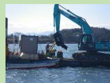
漁場内のがれき等の除去作業
