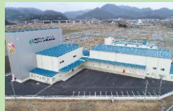
営農再開に向けた施設整備
