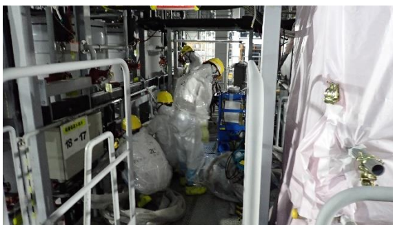
(写真 1－1) 系統復旧作業の実施状況①
