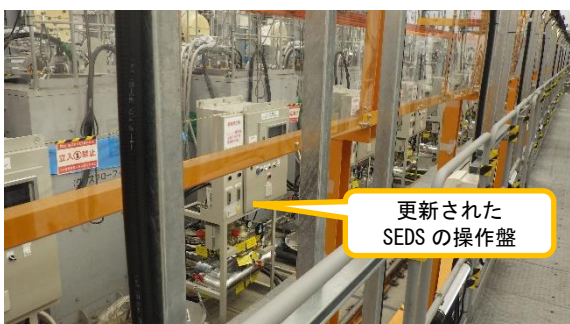
(写真 3) スラリー抽出装置（SEDS）の 更新完了を確認
