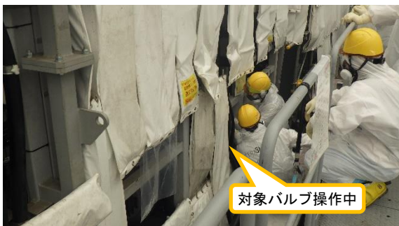
(写真 1 - 2) 前処理装置 (A 系) に係る水移送 (排水処理) の作業状況②
