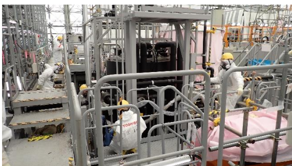
(写真 2－2) 前処理設備（A系）に係る3D超音波 探査試験等の実施状況②
