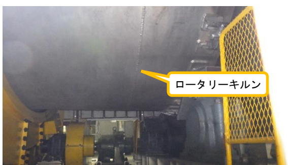
(写真2-3) ロータリーキルン下部の外観
