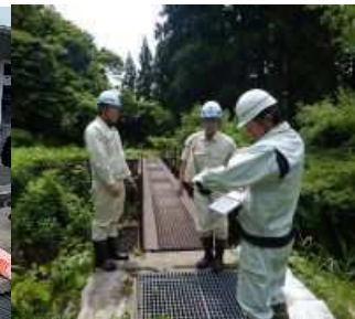
農業水利施設の 合同診断
