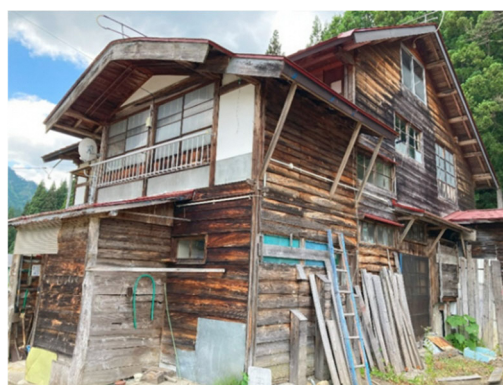
老朽化した空き家
