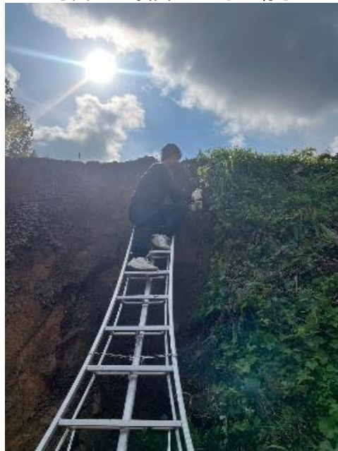
写真 22. 斜面にいきを打つ様子
