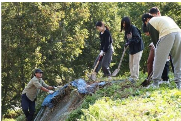
写真 21. 設置されていたブルーシートを撤去する様子
