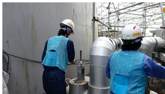
(写真1②) 連結弁の全開作業
