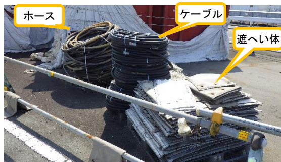
(写真 1 ④) エリアU西側の状況
