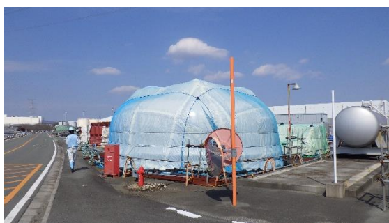
(写真 1 ①) エリアU東側の状況
