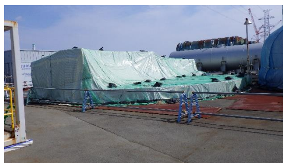
(写真 1 ②) エリアU東側の状況
