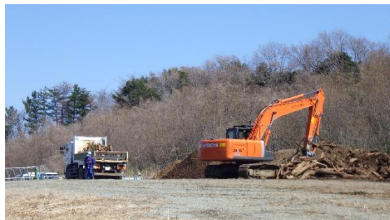
(写真 1 ④) エリアH東側の状況
