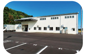
相馬事業所に新しく第二加工棟が竣工しました
