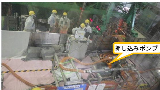
(写真1－1) 押し込みポンプの設置状況
