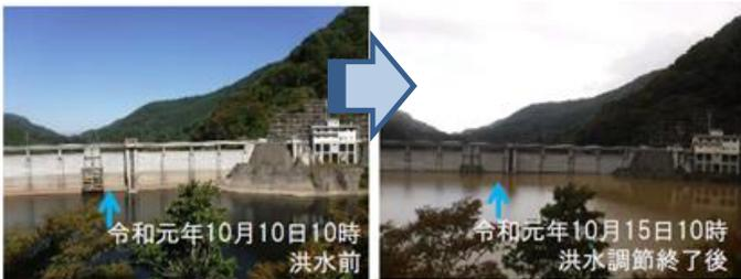
令和元年東日本台風(令和元年10月12日～13日)時に、東山ダムでは1.34万m<sup>3</sup>(東京ドーム約1杯分)の洪水を溜め、下流の河川の水位を約1.0m低下させました。
