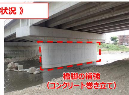
震度6弱の地震後でも、落橋・橋脚倒壊、路面の段差など通行不能となるような被害は無く、橋梁の機能を確保することができました。
