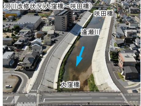
逢瀬川では、現在、甚大な被害を受けた昭和61年8月台風第10号の時と同規模の降雨となった場合も、**洪水による浸水被害を解消**できるよう、築堤護岸等の整備を進めています。
