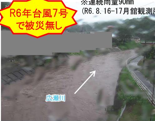
これまでは、河道内に土砂が堆積しており、洪水時に河川の流れを阻害していましたが、土砂を撤去することで河川断面が、約30%増えました。
