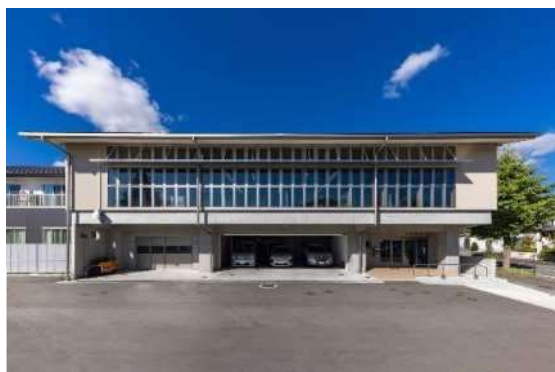
須賀川土木事務所(R2.3月竣工)
