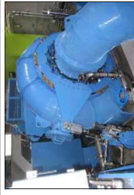
発電所内 横軸フランシス水車
