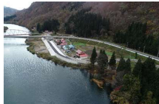
現況（湯倉地区）
