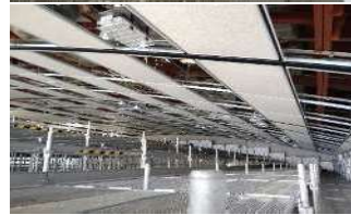
体育館(天井)の耐震改修
