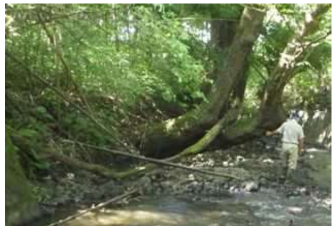
6 牛沢川(国見町)【溪流保全工】
