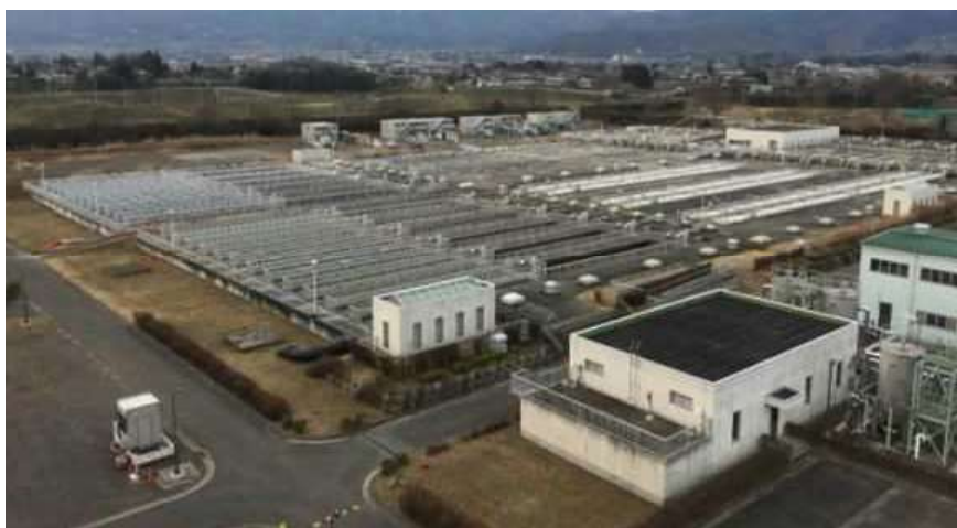
県北浄化センター
