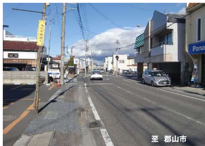
8 吹上荒町線(本宮市)【電線共同溝】
