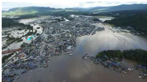
夏井川（いわき市）の施工状況
