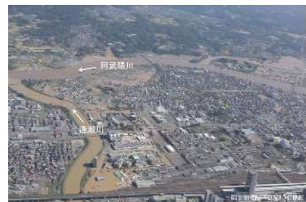
令和元年東日本台風の被災状況
