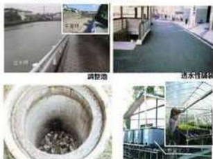
雨水貯留浸透施設の例
