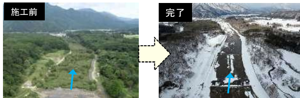
(河道掘削) 加藤谷川(下郷町)
