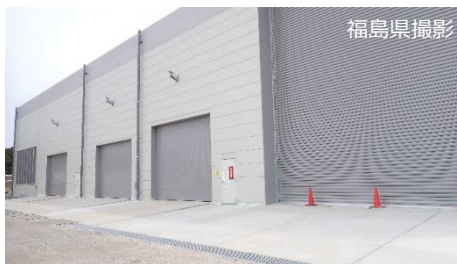
減容処理設備の外観
