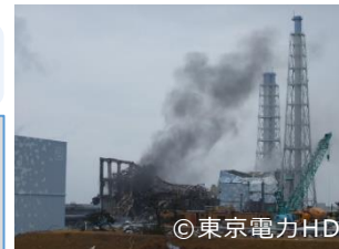
水素爆発を起こした直後の3号機
