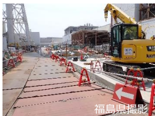
フェーシング前 (3号機付近)
