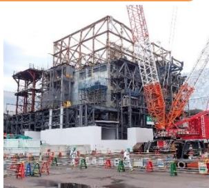
1号機の大型カバー設置の様子
