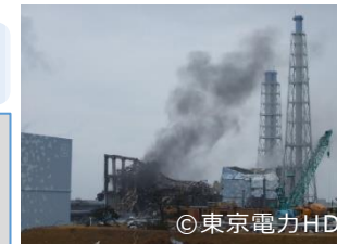
水素爆発を起こした 直後の3号機
