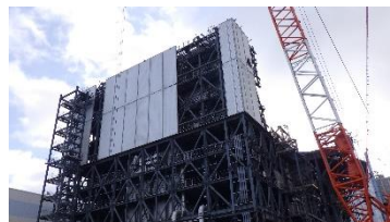
1号機の大型カバー 設置の様子
