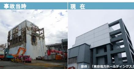
2011年3月15日水素爆発により上部が大きく破損した。原子炉建屋周りにカバーを設置し、燃料取り出し完了。
