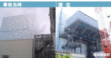
水素爆発は回避されたが、原子炉建屋側面のパネル開放により格納容器から建屋内に漏れ出ていた多くの放射性物質を放出した。原子炉建屋横に前室を設置し、内部調査等を行っている。
