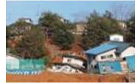
家屋被害：福島市
