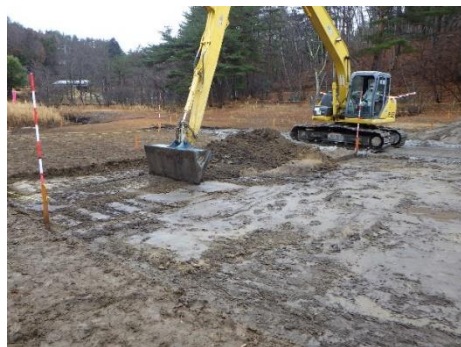
ため池の底質を掘削除去する様子
