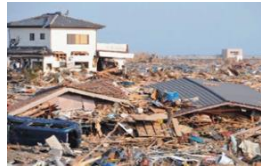
津波被害：浪江町
