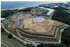
中間貯蔵施設の様子
