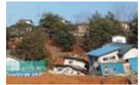
家屋被害：福島市
