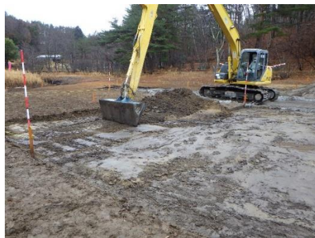
ため池の底質を掘削除去する様子
