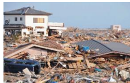
津波被害：浪江町
