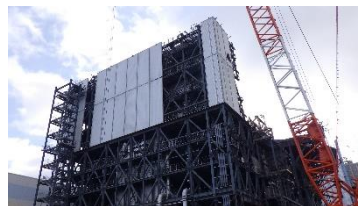
1号機の大型カバー 設置の様子
