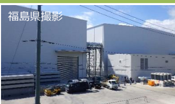
固体廃棄物貯蔵庫第10棟の外観 (左: B棟、右: A棟)
