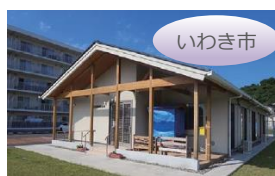
公営住宅敷地内：集会場
