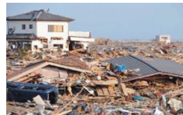
津波被害：浪江町
