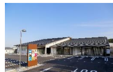
大熊町：商業施設
