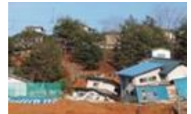
家屋被害：福島市
