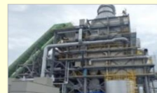
仮設焼却施設
