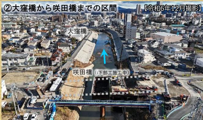
②大窪橋から咲田橋間の築堤護岸及び堤防道路が令和4年度に完成しました。(咲田橋施工範囲を除く) 現在、咲田橋架け替えのため旧橋を撤去し、新しい橋梁の下部工を実施しています。
