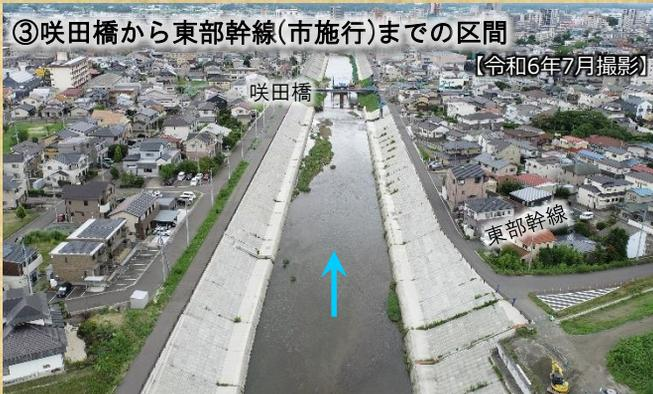
③咲田橋から東部幹線間の築堤護岸及び堤防道路が完了しました。
