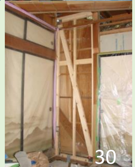
耐震改修の状況
