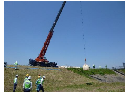
大型土のう工
