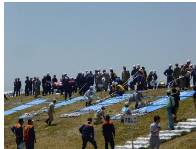
シート張り工
