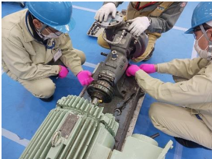
ポンプ分解・組立の様子
