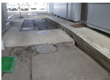
写 3-4 宅地地盤の沈下の例
