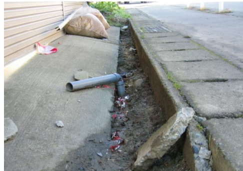
写 3-5 宅地地盤の段差の例
