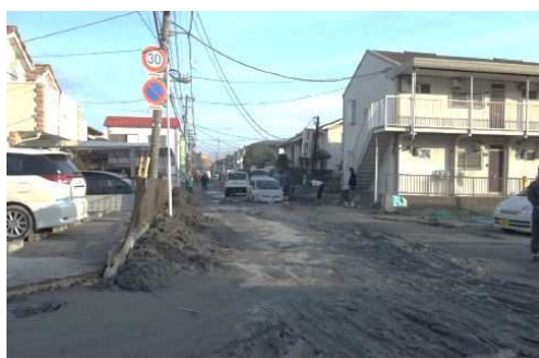
(a) 液状化の被害
