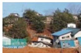
家屋被害：福島市
