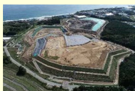
中間貯蔵施設の様子
