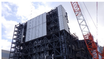
1号機の大型カバー 設置の様子
