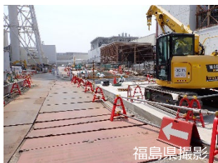
フェーシング前 (3号機付近)
