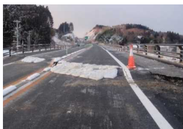
写真 土嚢での応急措置
