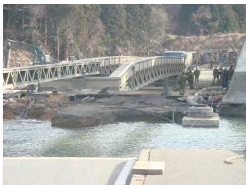
写真 応急仮設橋による通行確保
