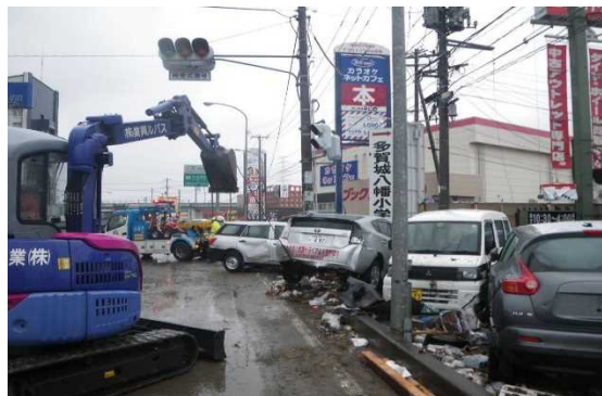
写真 災害時の撤去作業状況
