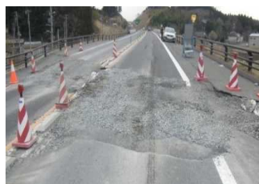
写真 碎石での応急措置
