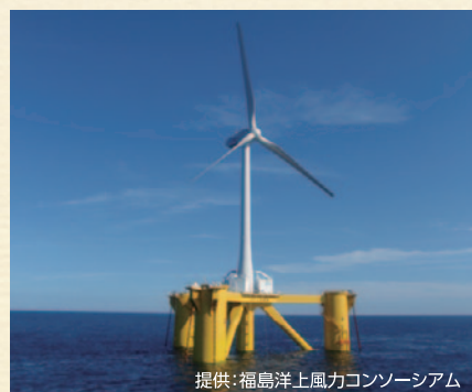
提供:福島洋上風力コンソーシアム
