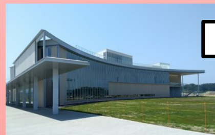
东日本大震災・原子力災害伝承館
