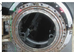
2号机组 反应堆存放容器贯通孔的堆积物清除后 (©IRID)
