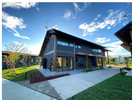
双叶町：站西住宅
