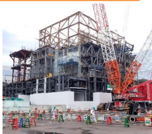
1号机组设置大型外罩的情景
