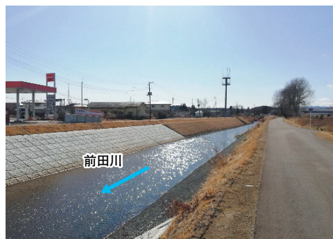
前田川(双葉町) 災害復旧工事
