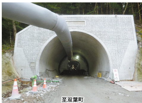
国道288号野上小塚工区(大熊町) 3工区中屋敷トンネル
