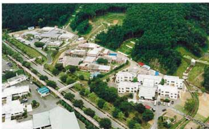
① 対策工後全景
