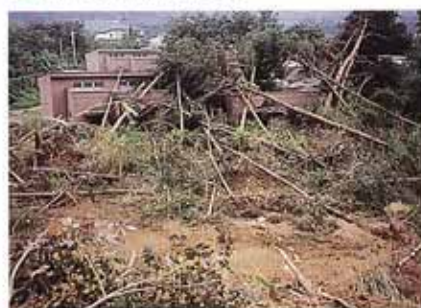
① けやき荘被災状況(一部損壊)
