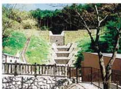
① 完成した砂防えん堤
