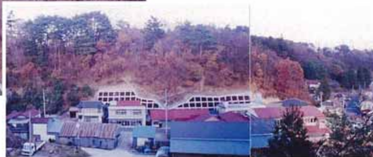
▲対策工後 （法枠工）
