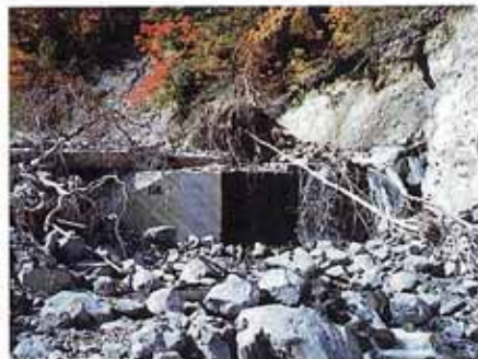
▲砂防えん堤(上流部)
