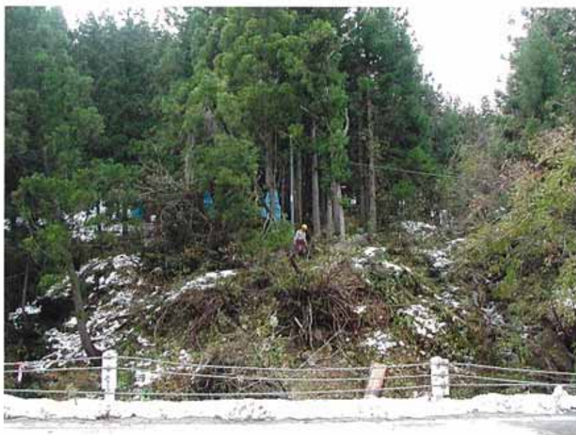
蓬萊地区地すべりブロック末端部の押し出し現象に伴う立木の傾倒状況
