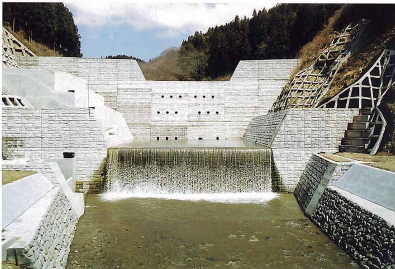
① 那倉川砂防えん堤 (碓町)
