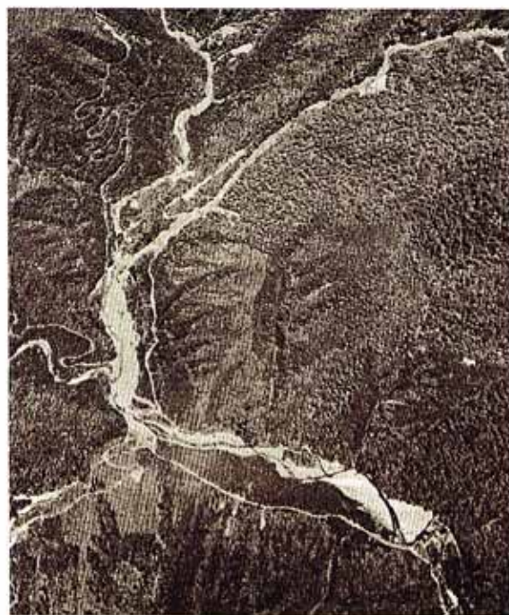
▲舟岐川上流砂防えん堤堆砂および荒廃状況
