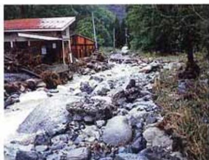
▲人家被災状況(下流部)
