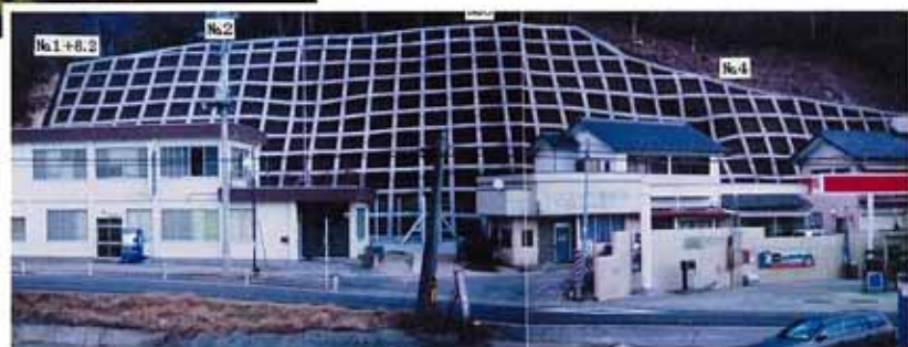
▲対策工後（法枠工）
