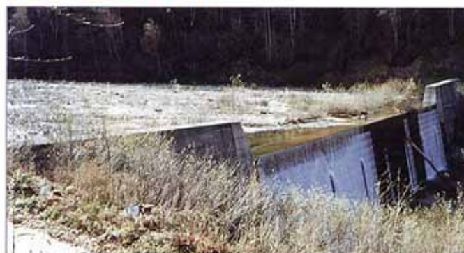
▲長須ヶ玉山砂防えん堤 (現在)
