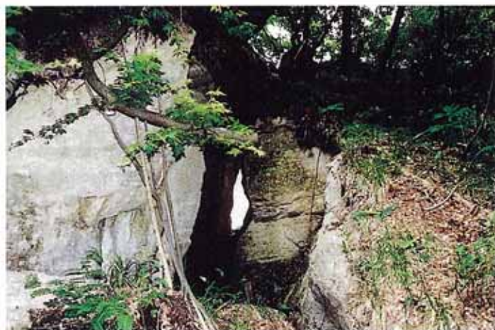
袖の沢地区に発生した亀裂
