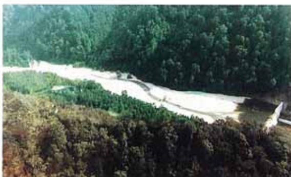
▲長須ヶ玉山砂防えん堤堆砂状況
